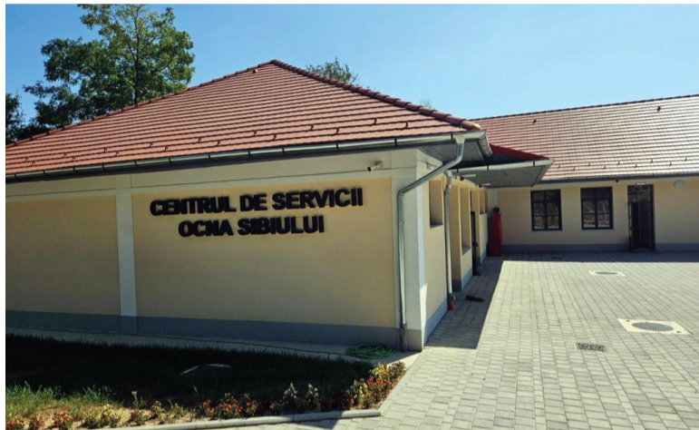
Centrul de servicii după reabilitare
