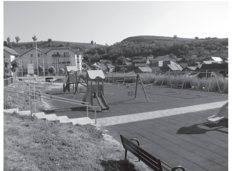
Parc ANL după reabilitare
