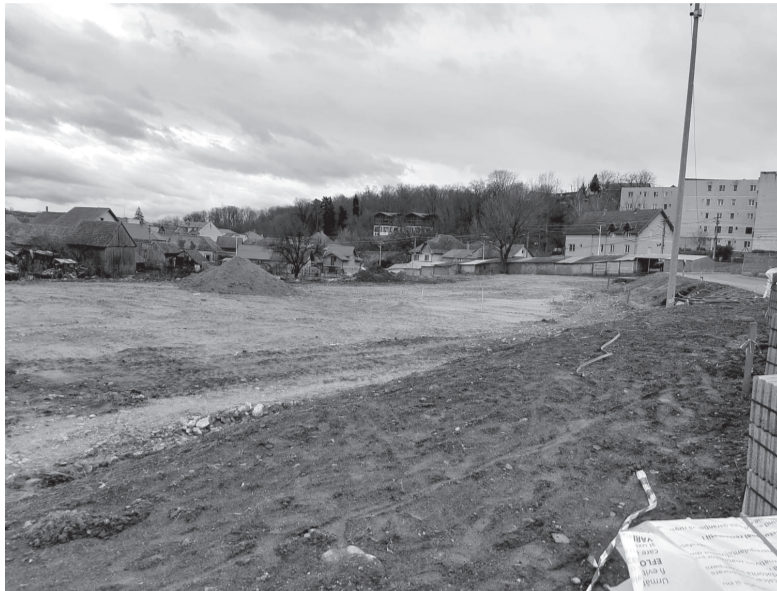
Parc ANL înainte de reabilitare
