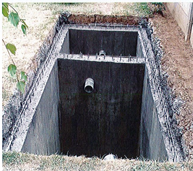
Bazin vidanjabil etanș din beton armat
